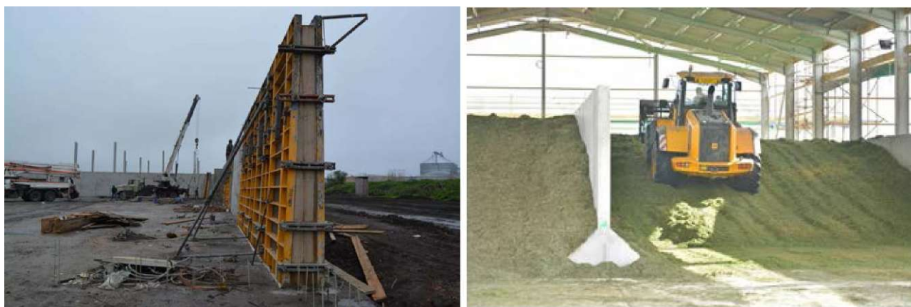
Рисунок 4 - Строительство наземного хранилища для хранения кормов
