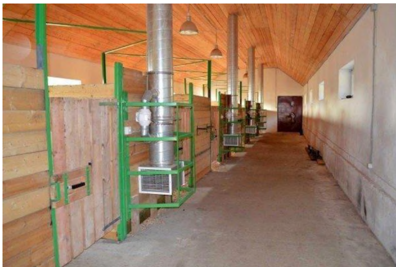
Рисунок 11 - Вентиляция в конюшне
