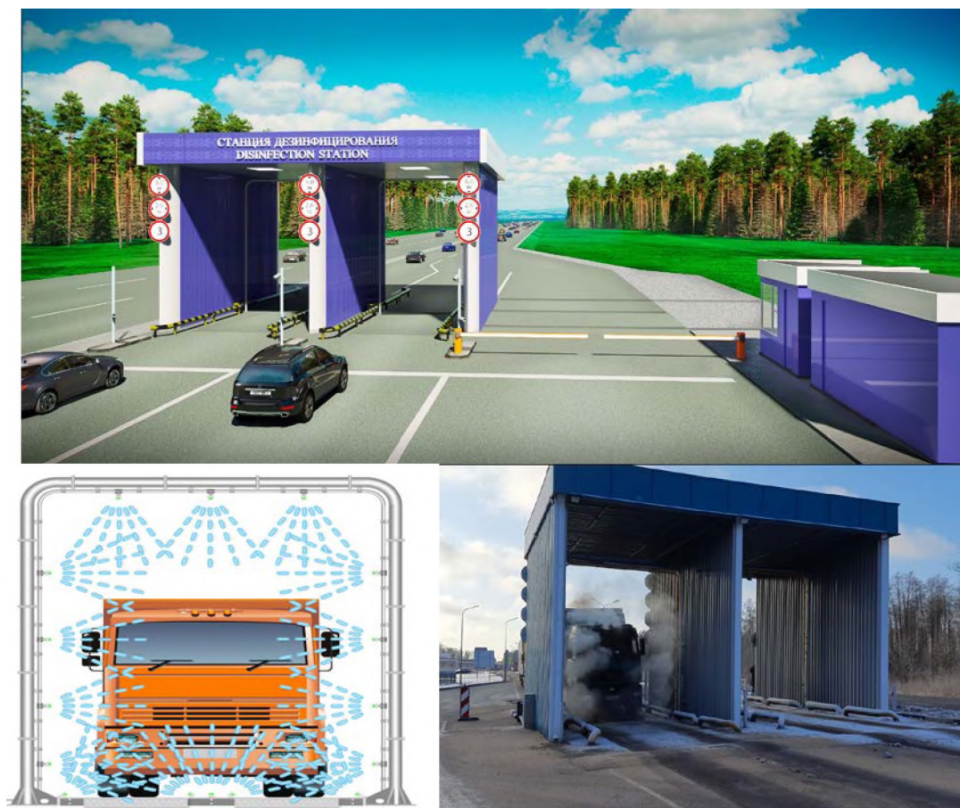
Рис. 1. Дезинфекционный арочный барьер
