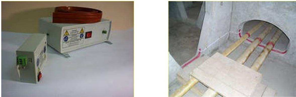
**Рисунок 10 – Охранно-защитная дератизационная система (ОЗДС)**
