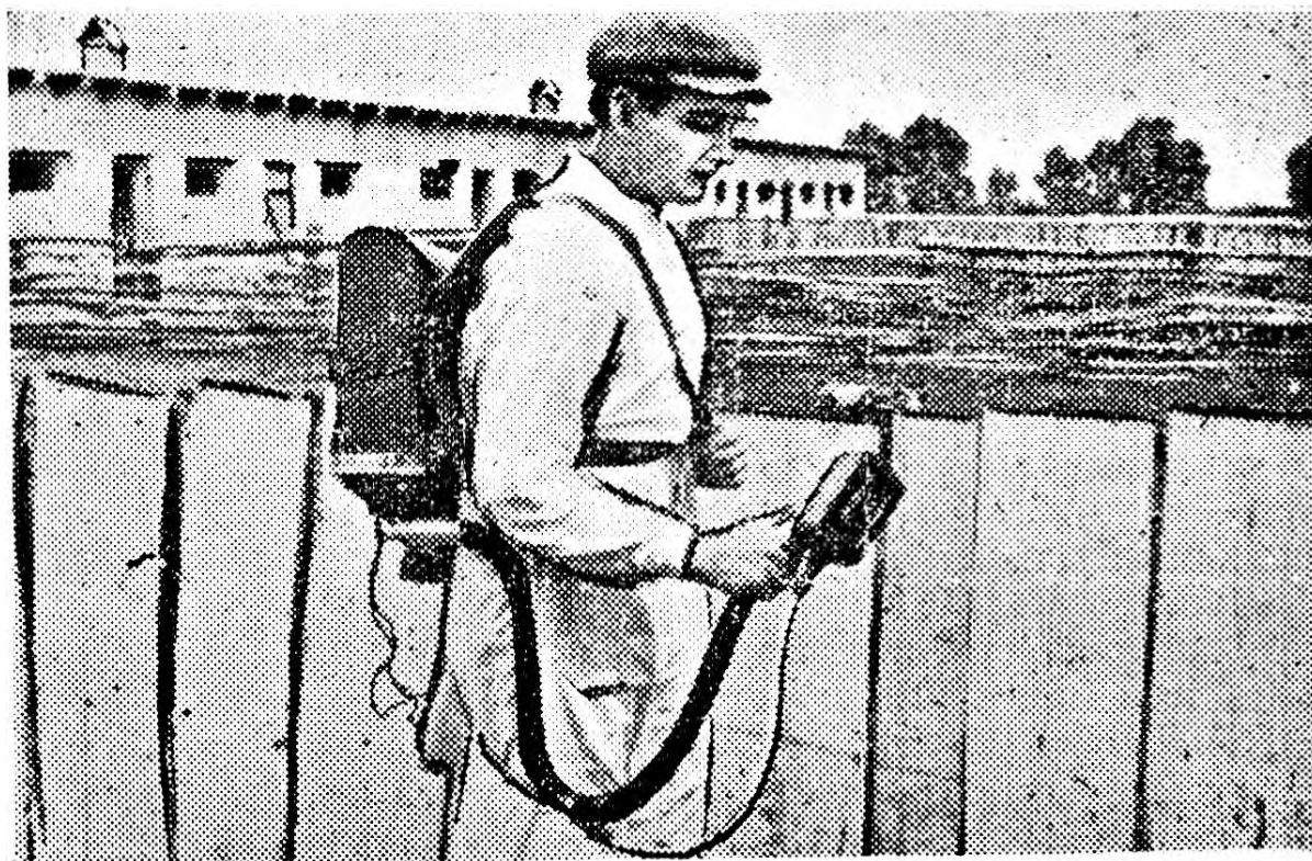
Рис. 4. Электромеханическая щетка в рабочем положении.
