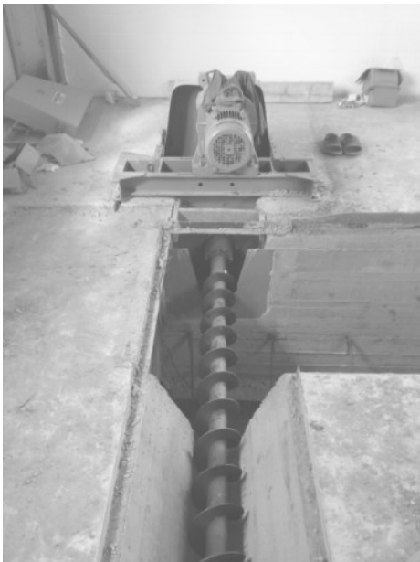
Рисунок 4 – Шнековый транспортер
