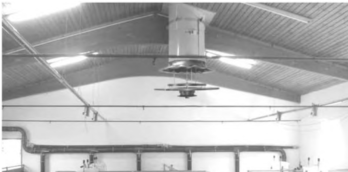
Рисунок 6 – Вентиляция с распределителем приточного воздуха
