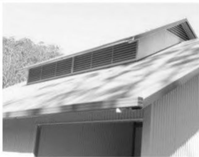
Рисунок 7 – Характерные отверстия для горизонтальной вентиляции
